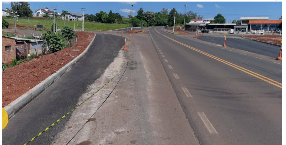
No trevo de Canabarro já foi feita a camada de asfalto nas laterais alargadas
