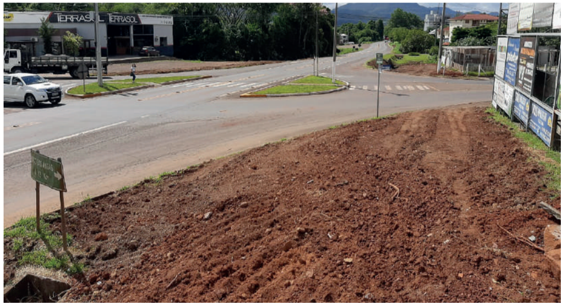
No trevo do Bairro Languiru a prefeitura realizou a limpeza e deve iniciar drenagem e terraplenagem
