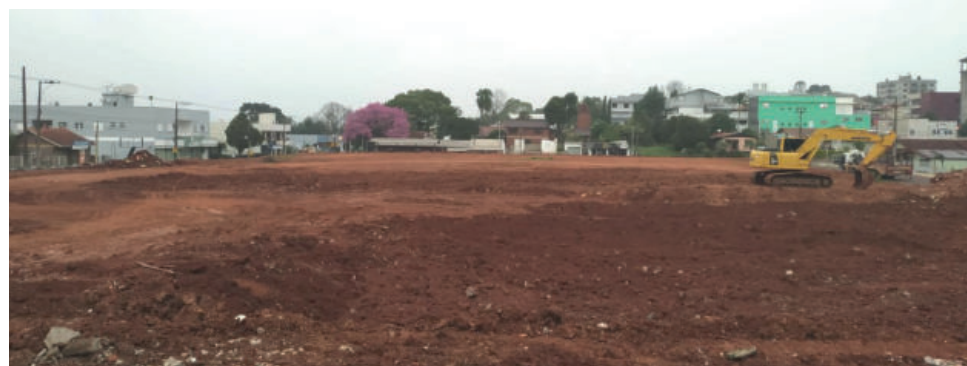
Obras de terraplenagem no campo do Canabarense
