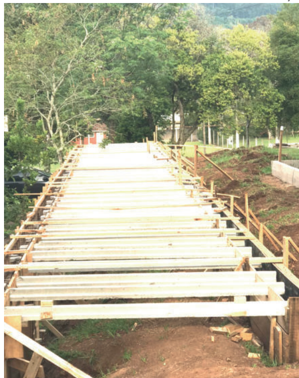
Obras em andamento na praça
